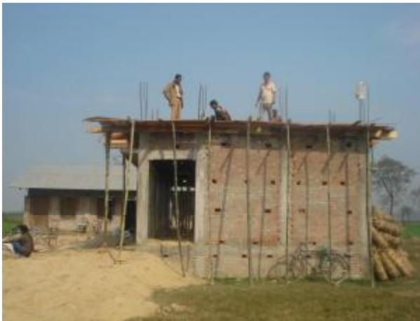
Bauarbeiter auf dem Dach eines Klassenzimmers der Sri Nepal Rastriya Grundschule-Bhaluibharbaliya.
