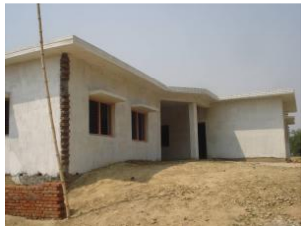
Die neuen Klassenräume der Sri Mahavir Grundschule sind fast fertig gestellt.
